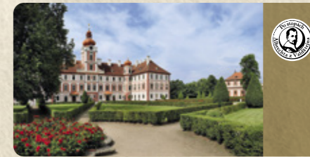
Zámek Mnichovo Hradiště
